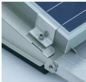
Der EPDM-Gummifuß wird bei Flachdach-Aufständersystemen von Photovoltaik- und Solaranlagen für alle leicht geneigten Flachdächer verwendet, um eine Beschädigung der Dachhaut während der Montage und dem späterem Einsatz zu verhindern.
